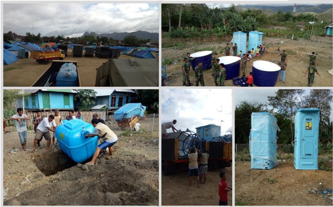
Gambar 36. Pemasangan Toilet Portabel dan Bio Septiktank di lokasi pengungsian (Sumber: Satgas PB PUPR Lombok, 2018)
