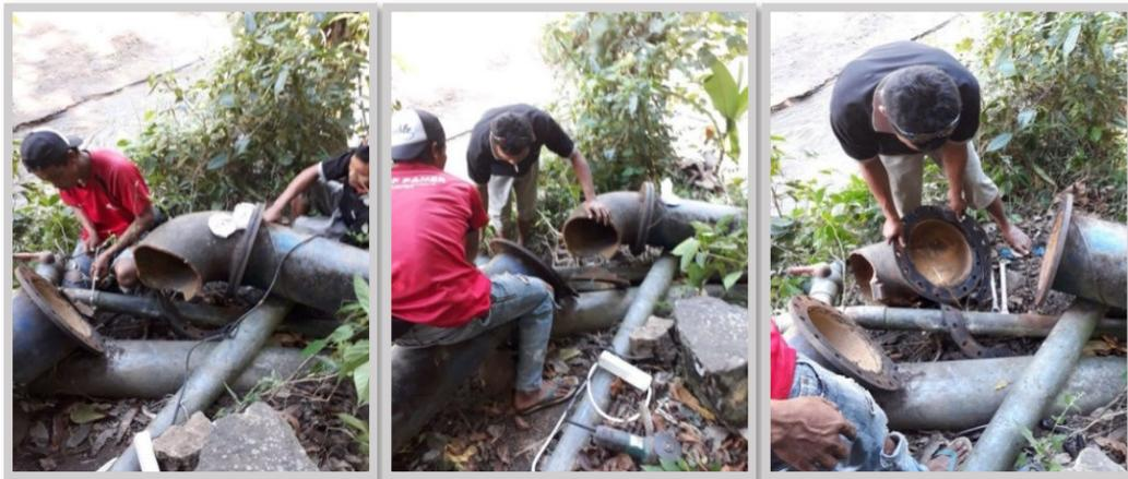
Gambar 12. Kerusakan infrastruktur Air Minum untuk IPA ANJA 40 l/dtk di Kec. Gangga-Kab. Lombok Utara (Sumber: Satker PSPAM NTB, 2018)
