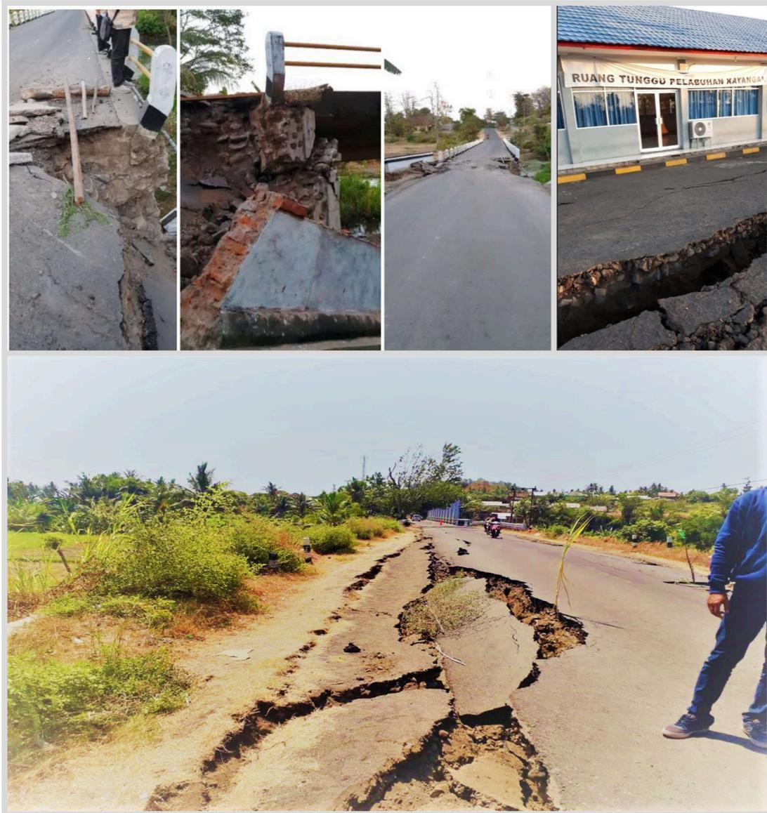
Gambar 28. Kerusakan Jalan dan Jembatan (Sumber: Satgas PB PUPR Lombok)
