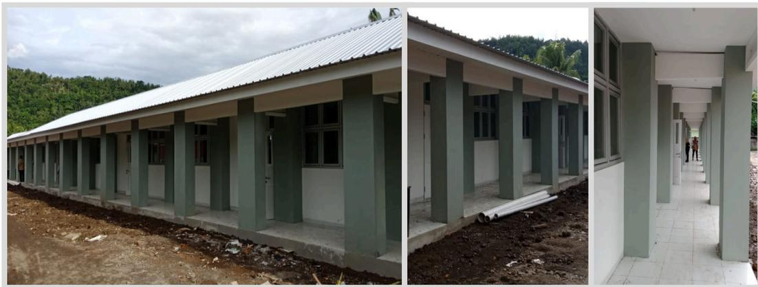
Gambar 49. Pembangunan Bangunan Sekolah Permanen SDN Guntur Macan, Lombok Barat (Sumber: Satker PBL NTB - Satgas PB PUPR Lombok, 2018)
