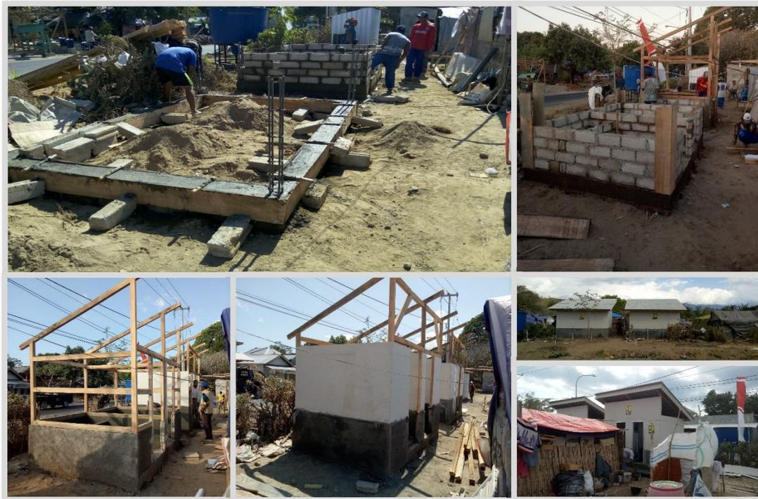
Gambar 37. Pembuatan MCK Komunal (Sumber: Satgas PB PUPR Lombok, 2018)
