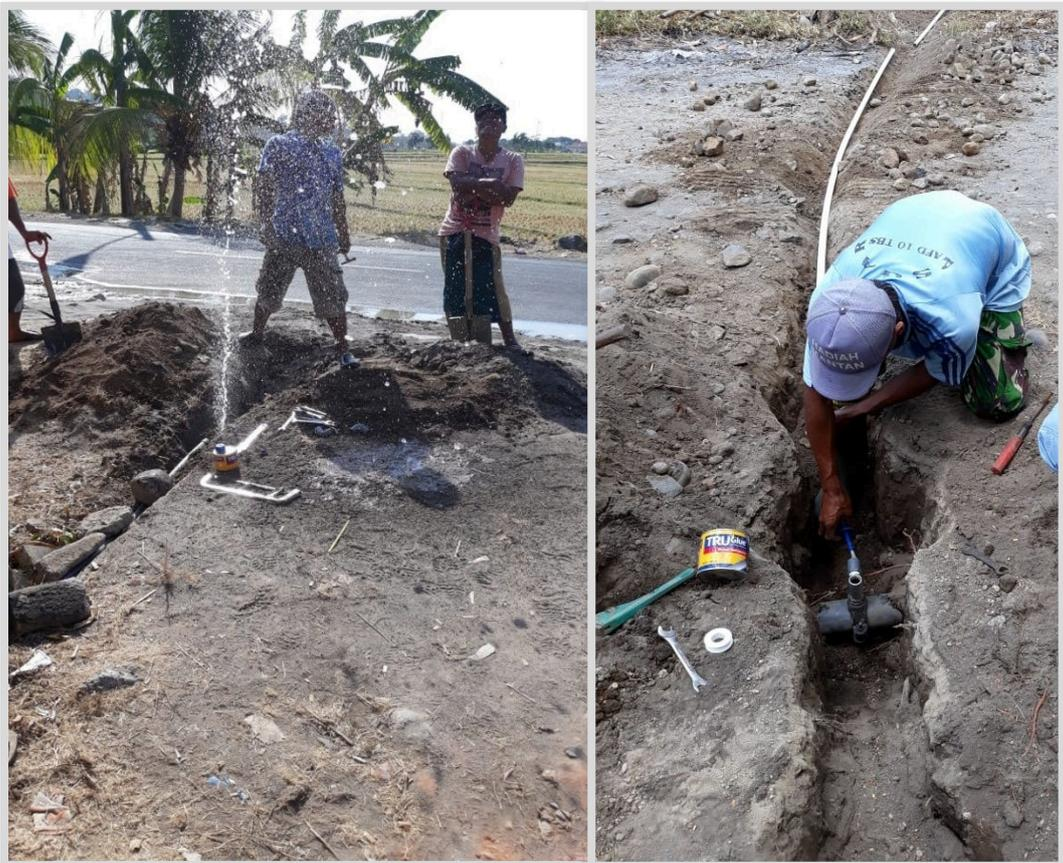
Gambar 40. Perbaikan Saluran Air Bersih (Sumber: Satgas PB PUPR Lombok, 2018)
