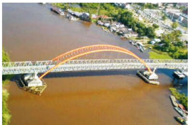
Foto 3.26. Jembatan Kahayan (Kalimantan Tengah)
