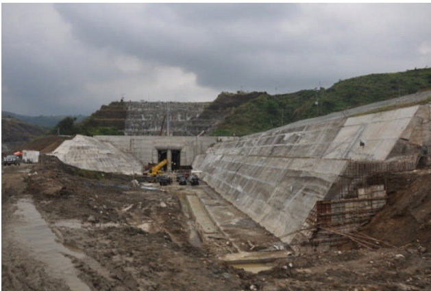
Foto 2.2. Pembangunan Bendungan Jatigede (Jawa Barat)
