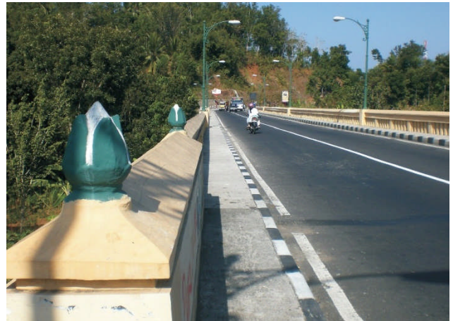
Foto 3.22. Jembatan Irung Petruk (DI Yogyakarta)
