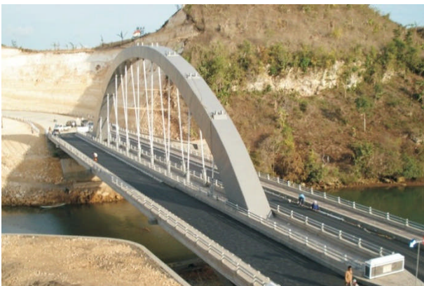
Foto 3.23. Jembatan Bajulmati (Jawa Timur)
