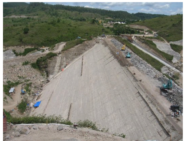
Foto 2.7. Bendungan Ponre-Ponre (Sulawesi Selatan)
