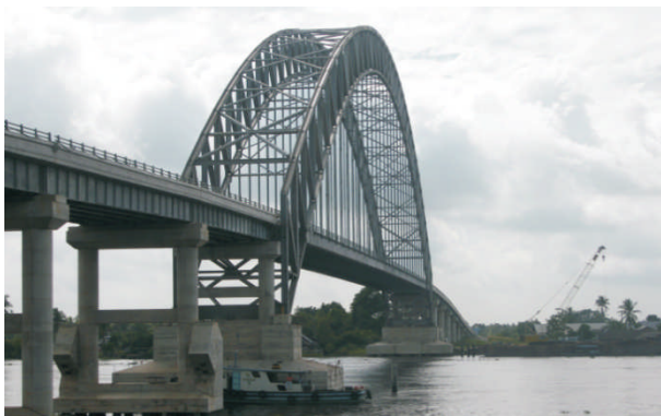
Foto 3.27. Jembatan Rumpiang (Kalimantan Selatan)
