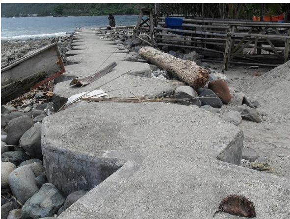
Foto 2.35. Pengaman Pantai Taludaa (Gorontalo)
