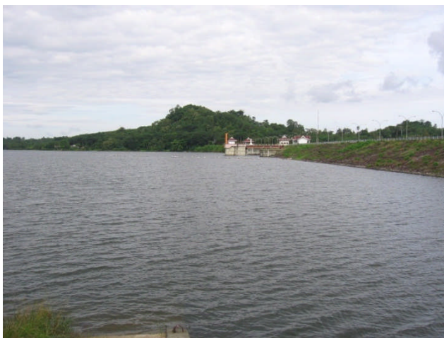
Foto 2.6. Bendungan Kalola (Sulawesi Selatan)
