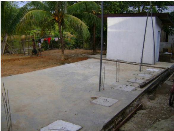
Foto 4.21. IPAL Komunal Kapuas (Kalimantan Barat)
