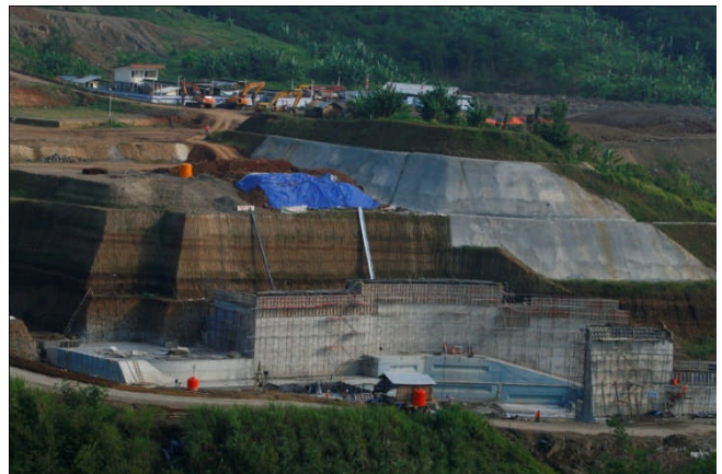
Foto 2.3. Pembangunan Bendungan Jati Barang (Jawa Tengah)
