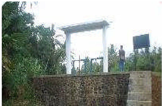
Foto 2.12. Bendung Pasir Eurih (Banten)
