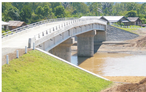
Foto 3.30. Jembatan Grant JICA (Sulawesi Tengah)
